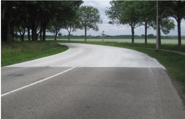
Foto: een stuk wegdek elders in het land voorzien van een witte toplaag
