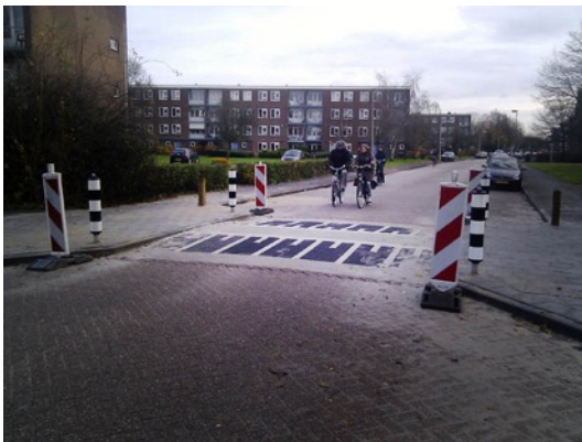
Foto: wegversmalling elders in het land waarbij reflectie is toegepast om de verhoging in het donker te zien.
